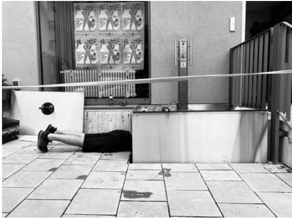
REPARATUR DES HUBLIFTS
